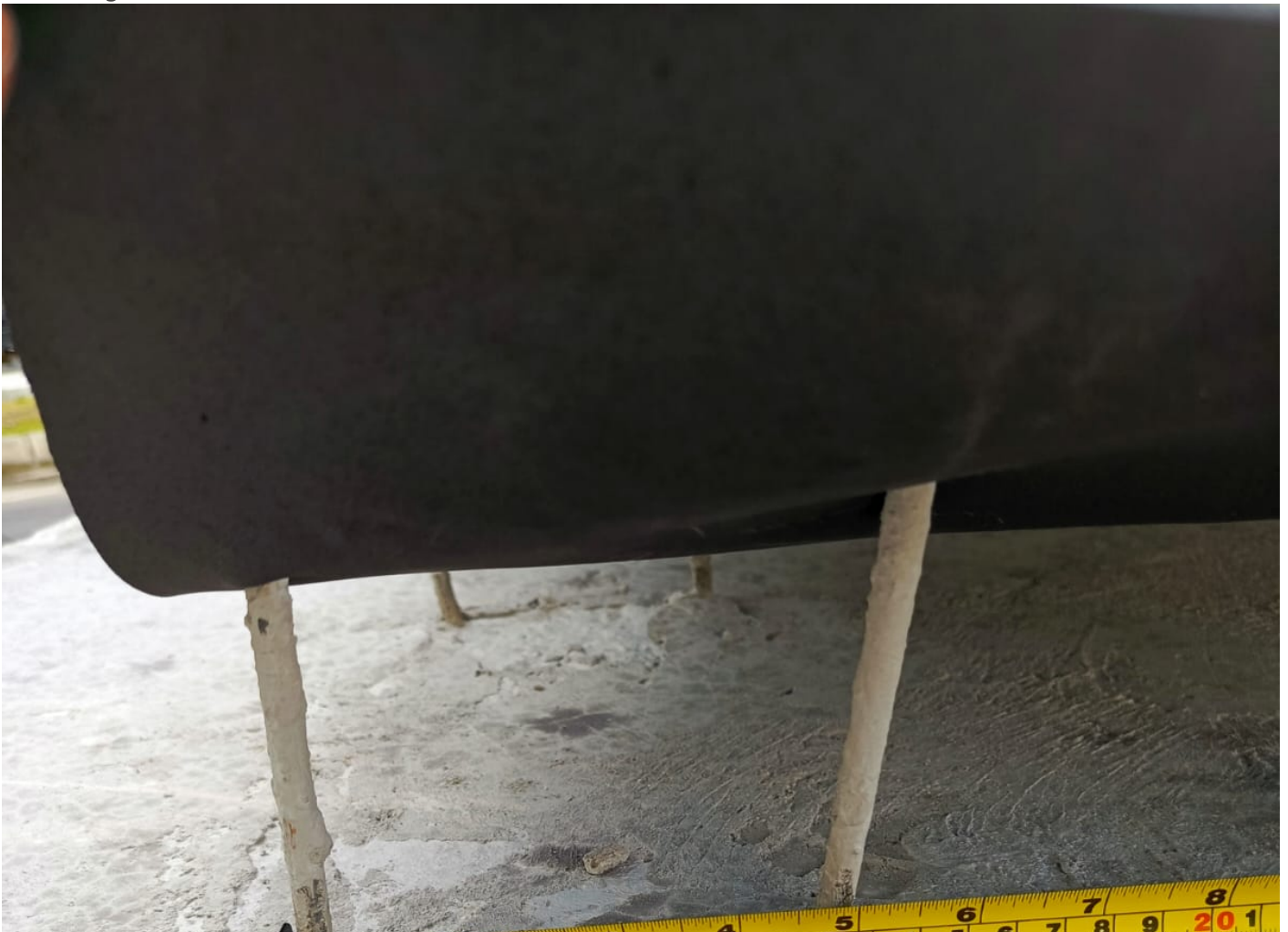
Jarak antar tiang besi bagian belakang dan depan 32 cm (total ada 5 tiang besi di depan dan belakang)
