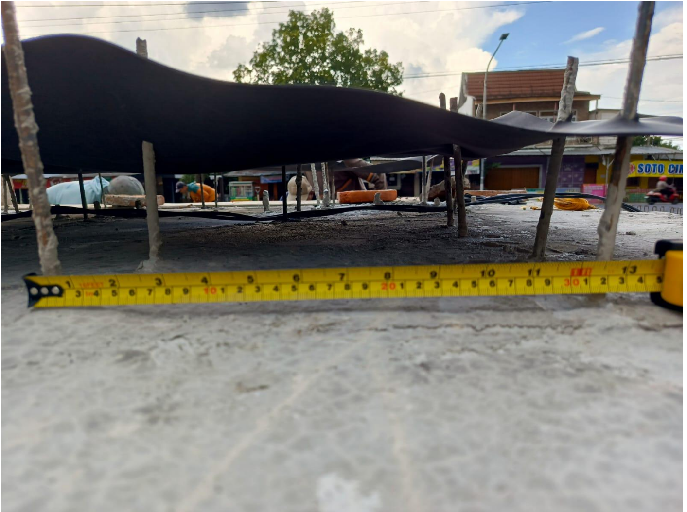
Jarak antar tiang besi bagian belakang dan depan 32 cm (total ada 5 tiang besi di depan dan belakang)
